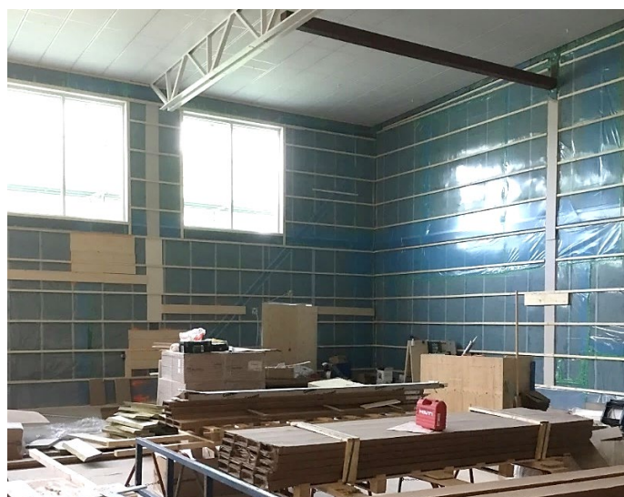
Figur 36. Plastfolie synligt vid montage, ytterligare exempel objekt 2, plastfolie kläms och tejpas.
