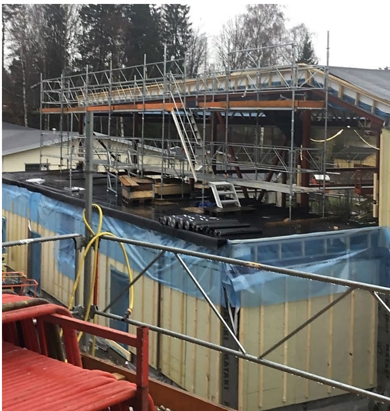
Figur 34. Byggnation av objekt 2.
