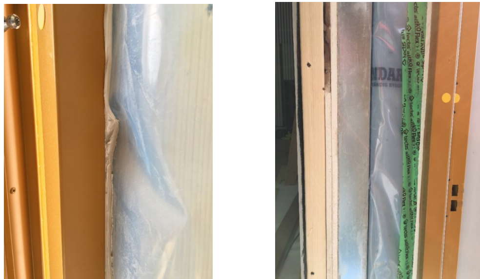
Figur 22. Exempel på anslutning mellan fönster och plastfolie samt dörröppning med tejp och fogmassa i objekt 1 (2018-04-18).
