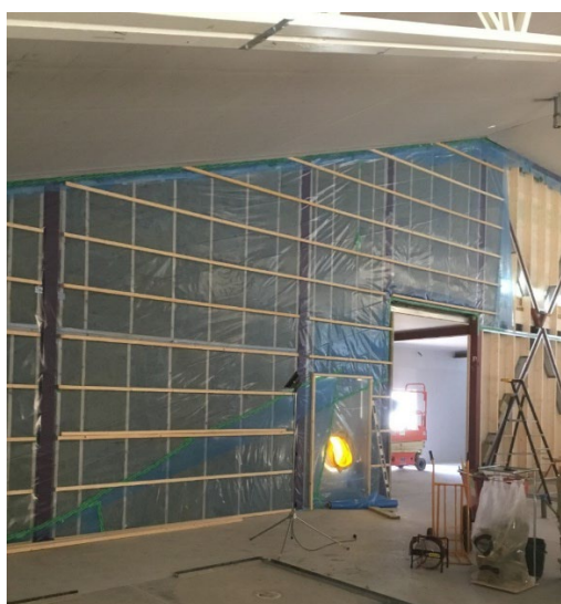
Figur 35. Plastfolie synligt vid montage, objekt 2, plastfolie kläms och tejpas.
