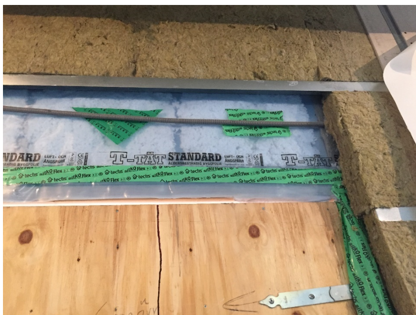
Figur 40. Exempel på temporär tätning av dörr, 2018-04-08.
