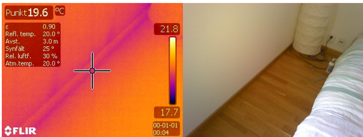
Figur 61. Golvvinkel, objekt 3, termogram och foto.
