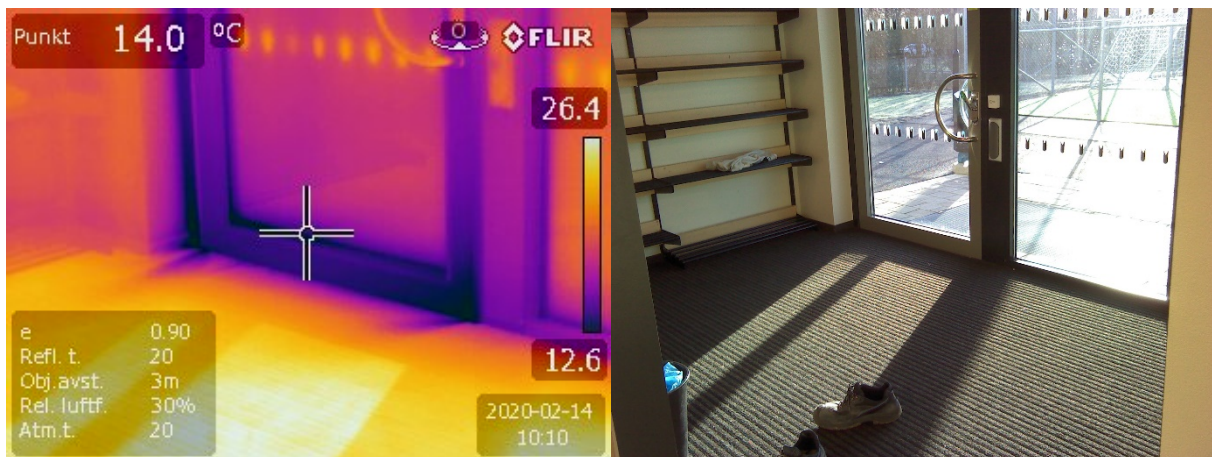
Figur 50. Dörrblad entrédörr, objekt 2, termogram och foto.
