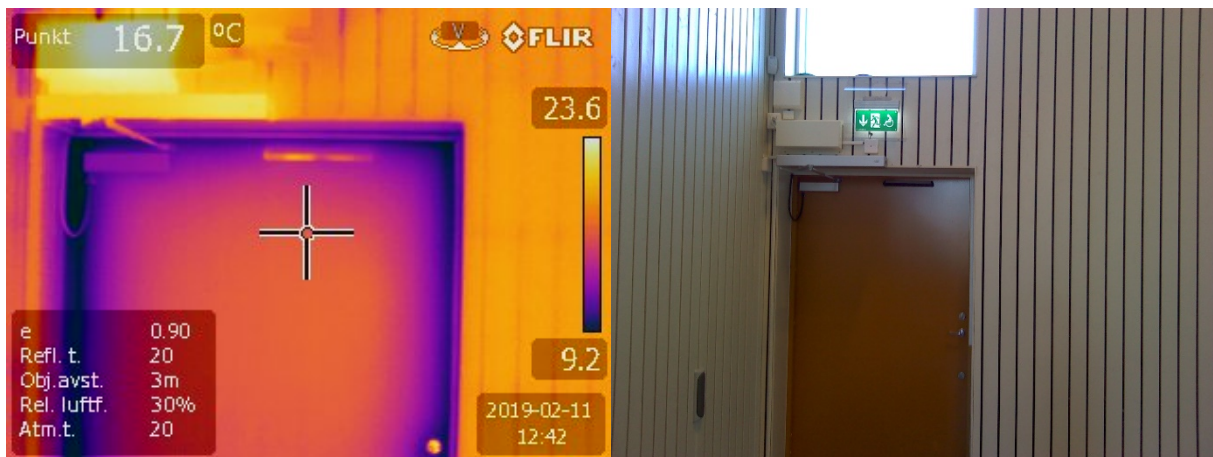
Figur 45. Övre del ståldörr, objekt 1, termogram och foto.
